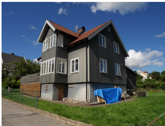
Huvudbyggnaden sett från Lyckogatan
