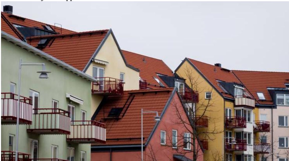
Sadeltak som utgångspunkt för stadsdelens taklandskap. Exempel från Järsla Sjö i Nacka.
