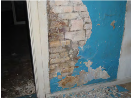
Bild 21. Murade vägg för skorstenen.
