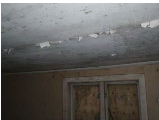
Bild 19 & 20. Mikrobiell påväxt på golv väggar och innertak.
