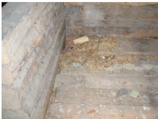
Bild 26. Isolering av halm.
