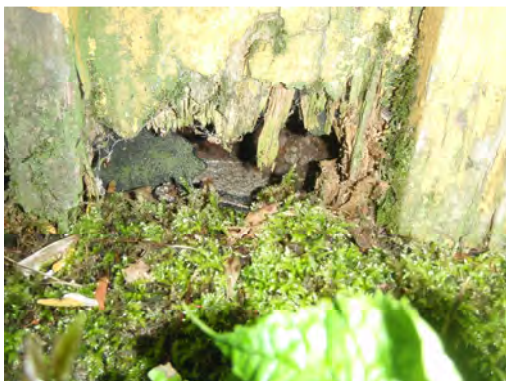
Bild 3 & 4. Röttskador i nederkant av fasad.
