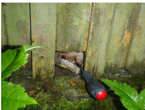
Bild 5. Röttskador i syll.
