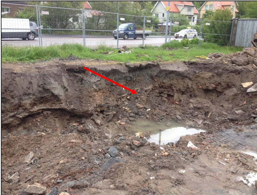
Bild 1. Rivningsmassor som lämnats kvar längs fastighetsgränsen mot Toltorpsgatan
