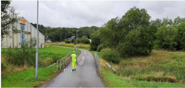
Gång- och cykelvägbro över Källeredsbäcken strax norr om tennishallen.
