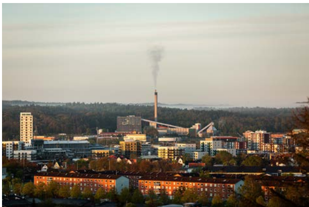
Riskullaverket ligger i Åbroområdet och försörjer kommunens invånare med el och värme. Foto: Rickard Olausson, Skvader Media
