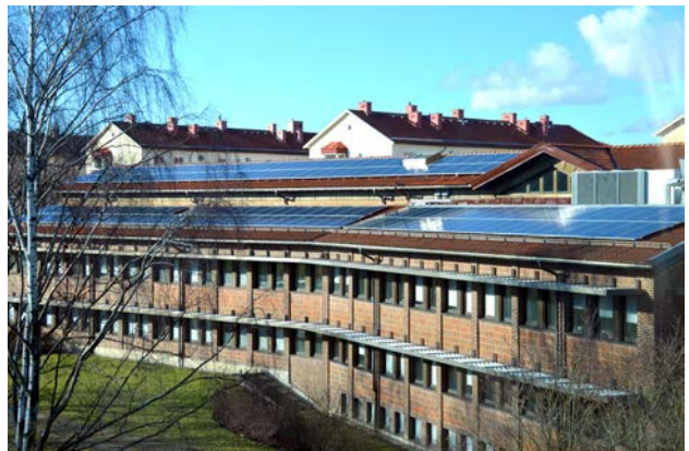
Solcellsanläggning på Mölnbalds stads stadshus. Foto: Sonja Skäär
