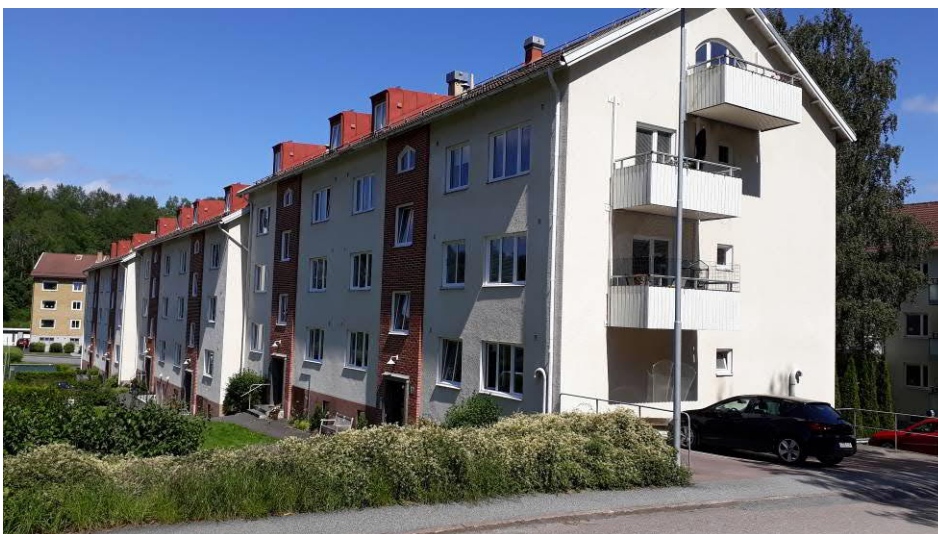
Fasad mot väster Hus nr 1
