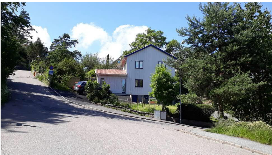
Fasad mot öster Hus nr 4
