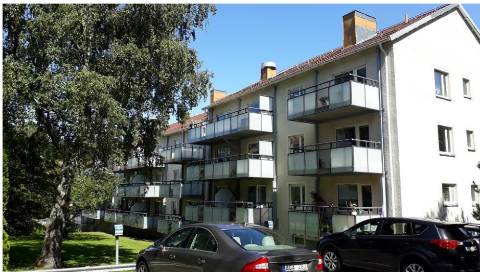
Fasad mot väster Hus nr 2
