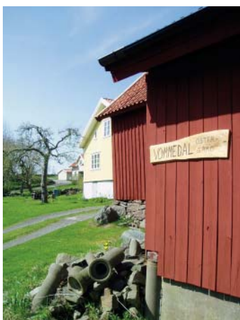
Den nya bebyggelsen har anpassats väl till den äldre för att bevara den värdefulla kulturmiljön
