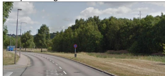
Trafikgrönytor mellan Söderleden och S Nedanvägsgatan, foto från Google maps
