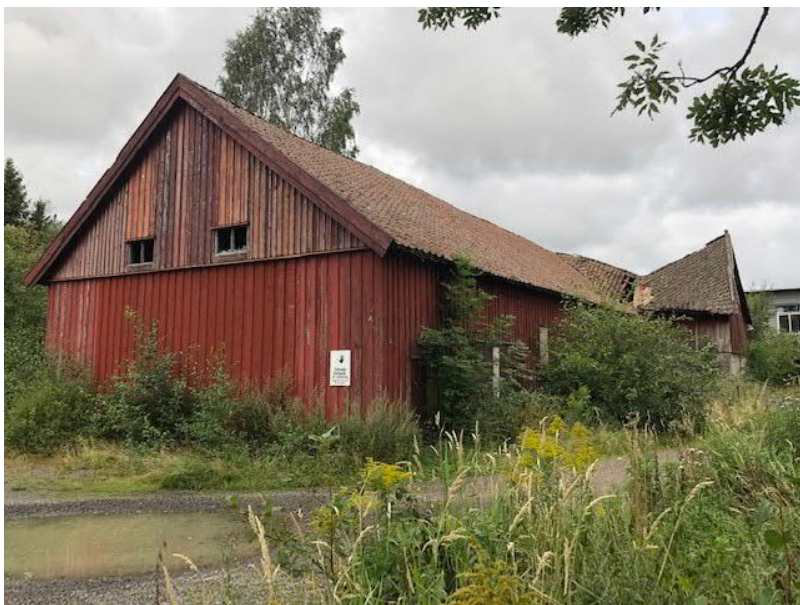
Foto på befintlig ladugårdsbyggnad taget från sydost
