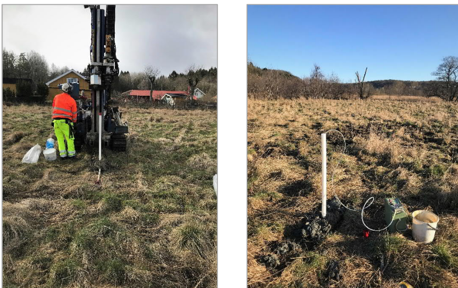
Figur 4. Bild t.v.: installation av ett av grundvattenrören i skruvborrhål. Bilden t.h. åskådliggör rensumpning i ett av grundvattenrören efter installation.
