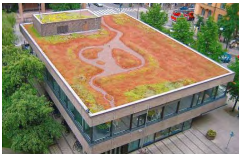
Figur 5. Exempel på sedumtak (Thyrens).
