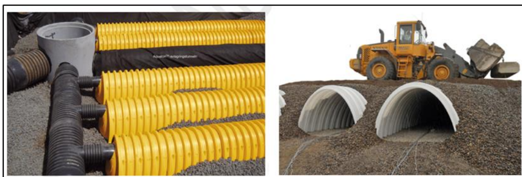
Figur 3. Exempel på perkolationsmagasin typ Milford Aquaton (Milford 2019).
