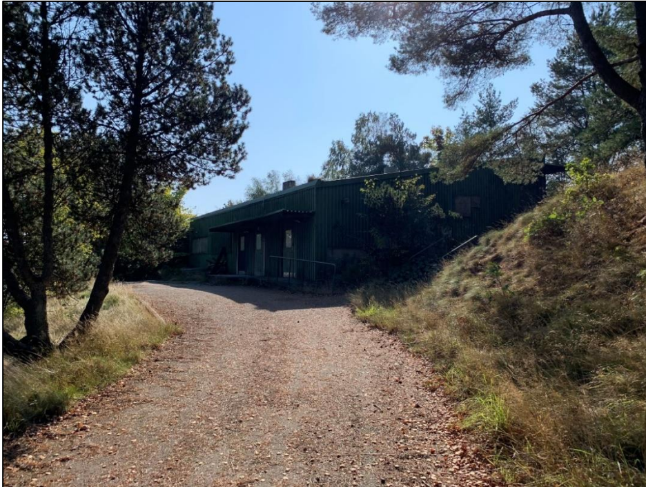
Bild 5.5 Befintlig byggnad i norr, vy från norr.
