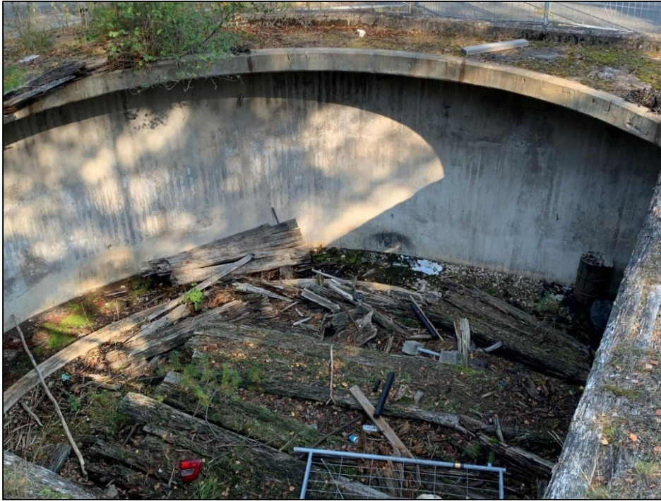
Bild 5.7 Betongkassun i södra delen av området (mellan punkt GS03 och GS04, se ritning G-P-01 i MUR/Geo).
