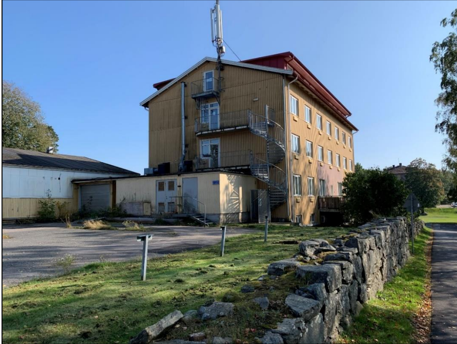
Bild 5.8 Befintlig bostadshus, vy från Stenmursvägen i nordväst.
