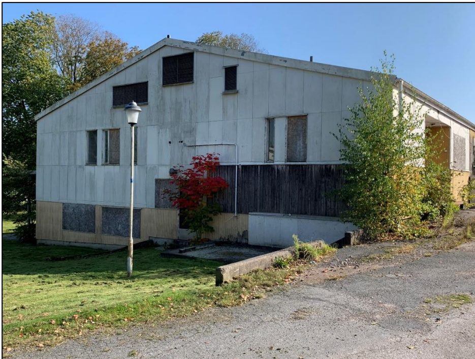
Bild 5.9 Befintlig byggnad/verkstadsbyggnad som ska rivas, vy från nordväst..
