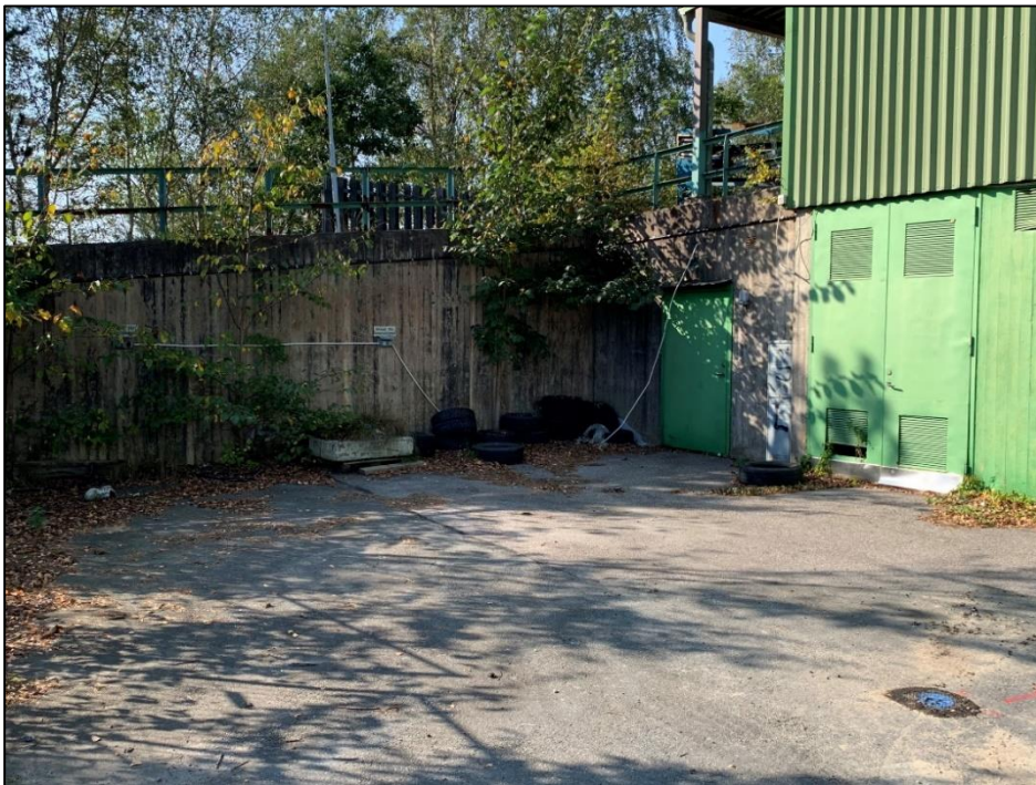
Bild 5.6 Befintlig verkstadsbyggnad samt stödmur i centrala delen av området, vy från öster.
